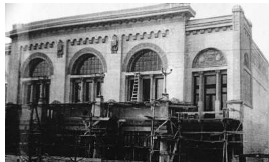
Главный фасад банка во время реконструкции. Архивная фотография 1912 года
