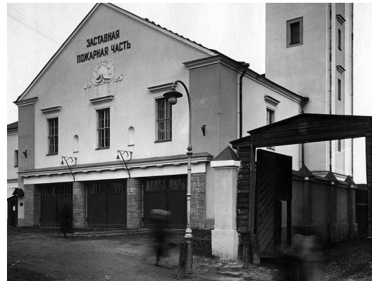
Заставная (Московская) пожарная часть. Архитектор Д. П. Бурый, Московский проспект, д. 116, 1925–1926
