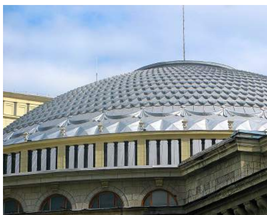
Новосибирский театр оперы и балета. Балюстрада и купол после реставрационных работ. 2008 год
