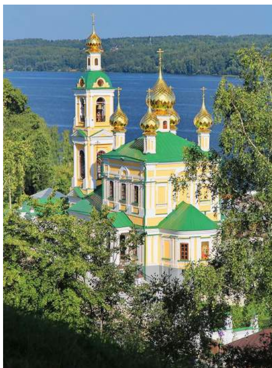
Воскресенская церковь, 1817 год. Ивановская область, г. Плес
