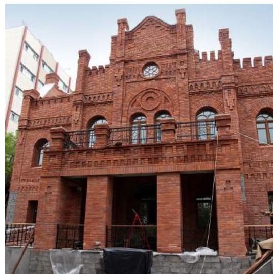
Особняк Лангелитье, май 2018 года Реставрационные работы ведутся ООО «Дальстройбизнес II»
